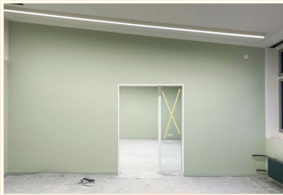
Abb.16: Grünes Schulzimmer im aktuellen Zustand des laufendes Umbaus im Dezember 2024.
