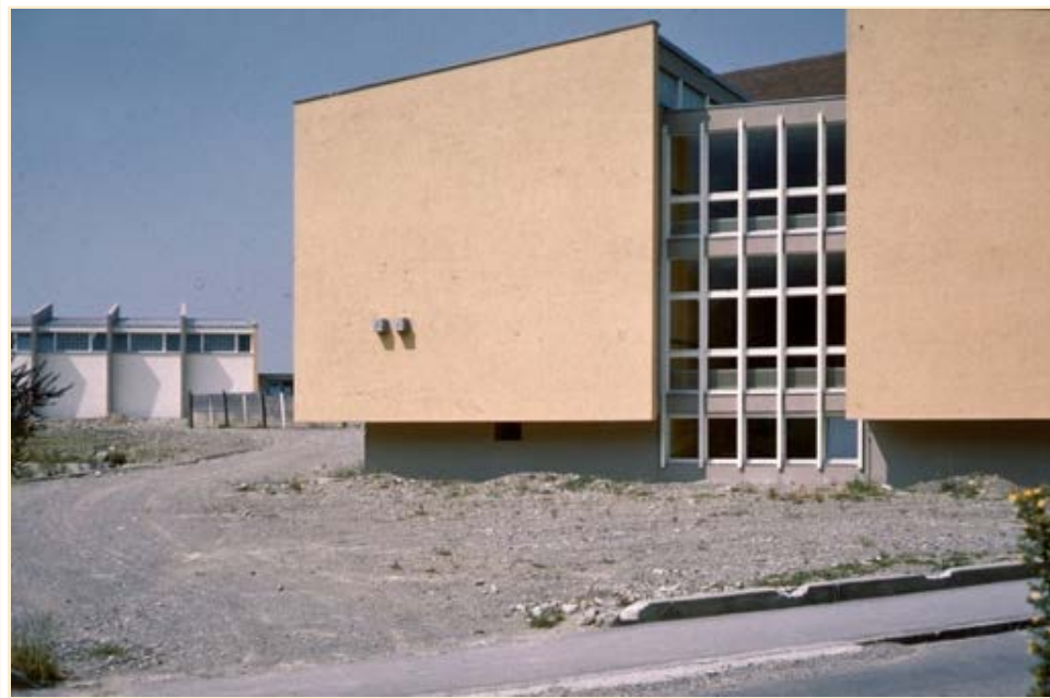
Abb.15: Die Stirnfassade der Primarschule Littau im Originalzustand 1961.
