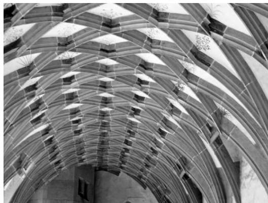
Abb. 6: Kreuzrippengewölbe des Klosters Maulbronn, Deutschland (13. Jahrhundert)
